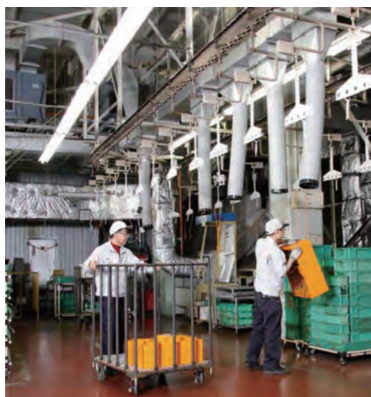
屋外設置でダクトを建物内部に引き入れた例
