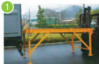
架台1をコンテナに接続
