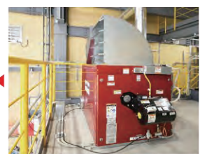
5 省資源無公害廃油暖房機
