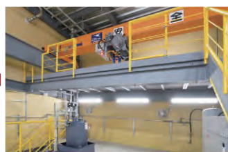
6 安全な点検階 (天井クレーン)
